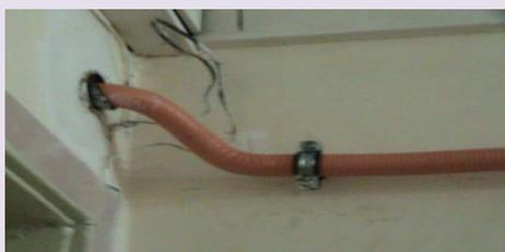
► Не требуется соединяющих деталей для монтажа труб благодаря высокой гибкости трубы.
